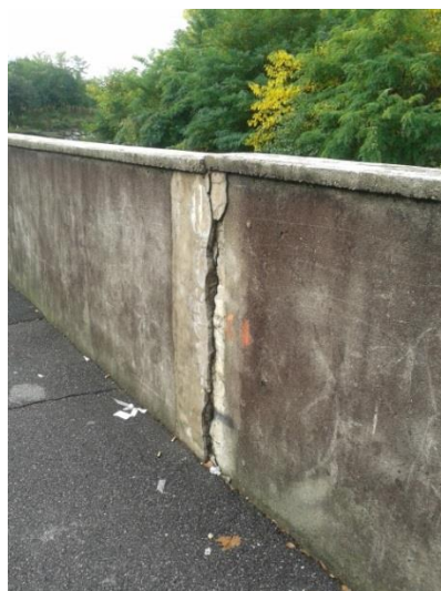
VISTA DELLE CREPE PRESENTI LUNGO IL MURO SPONDALE DI VIA GHILINI
