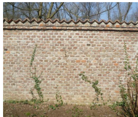
MURATURA INTERNA CON MATTONI DI TESTA
