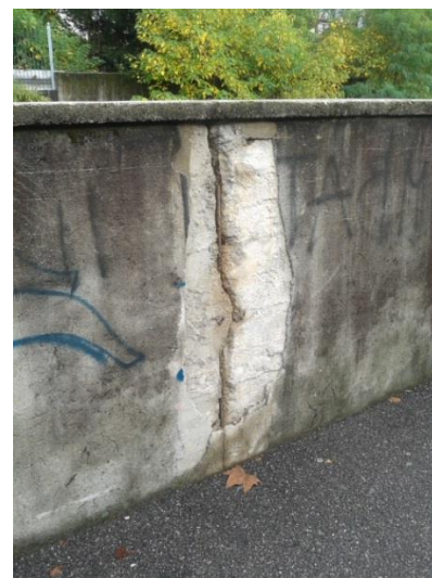
VISTA DELLE CREPE PRESENTI LUNGO IL MURO SPONDALE DI VIA GHILINI
